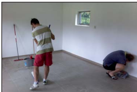
Úklid zrekonstruovaných kabin
